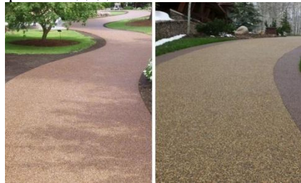
Рис. 1. Паркові доріжки з використанням екобетон
